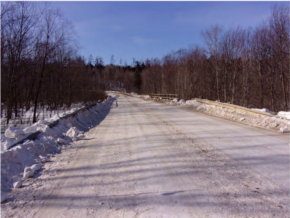
Фото №3. Вид на мост со стороны конца трассы.
